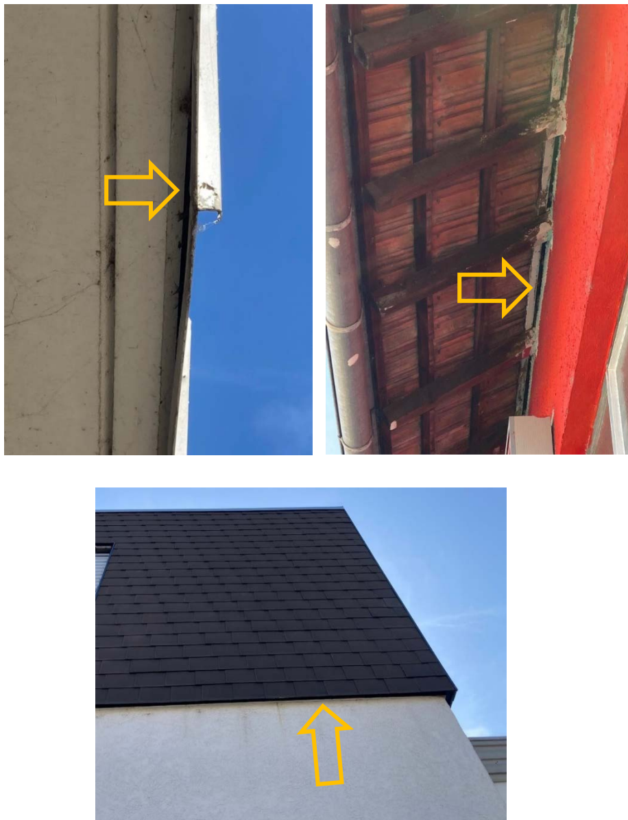
Abb. 2: Potenzielle Fledermausquartiere an den zum Abriss vorgesehenen Gebäuden
