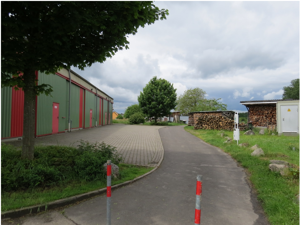
Abbildung 3: Norden der Lagerhalle
