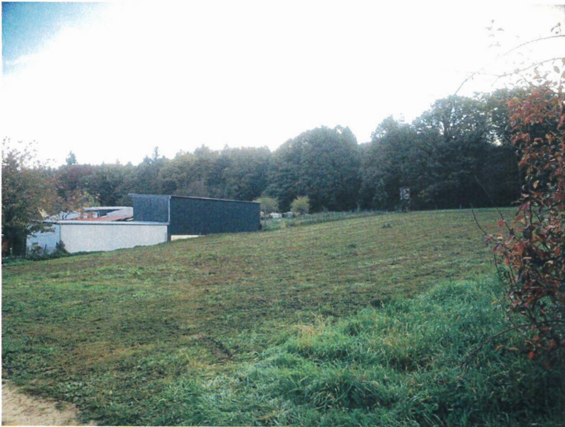
Bild 3: Betriebsgebäude und Ackerfläche
