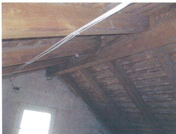
Abb. 1: Östliche Hälfte des Dachstuhl Gebäude Eichenstrasse 8
