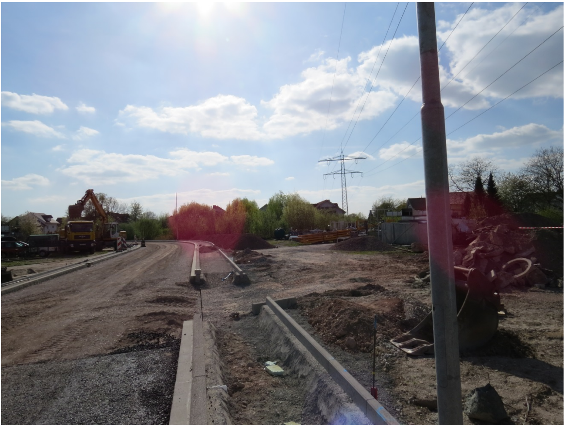
Abb. 7: Straßenneubau „In den Lissen“
