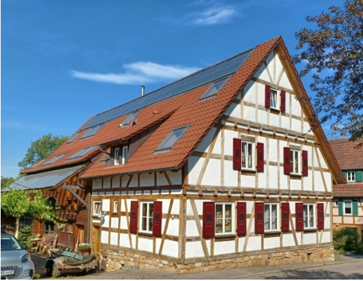
Modernisierung von Gebäuden
