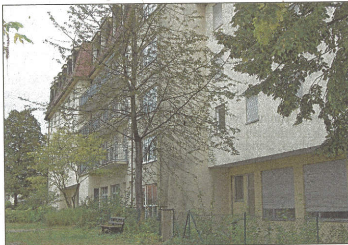
Ein Teilbereich des St.-Vinzenz-Hauses ist für öffentliche Nutzung vorgesehen.
